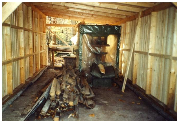
Die Seitenwände sind verschalt, die Stirnwände sind noch offen. Die Saftpresse ist gut verpackt. [AP]
